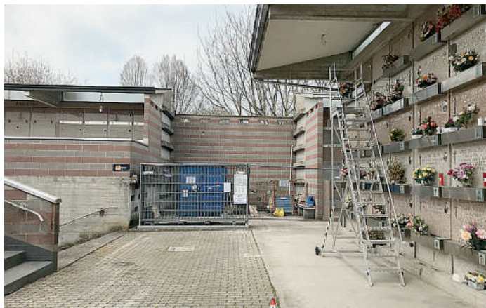
L'ala del cimitero di Roveleto interessata dal doppio cantiere
